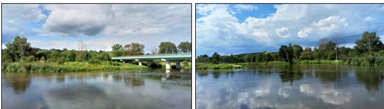
Fot. 2. Pilica i most na rzece w ciągu drogi wojewódzkiej w Wólce Magierowej
